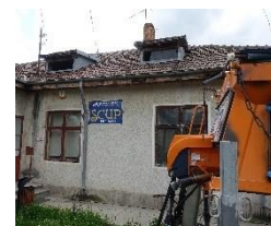
SCUP SRL (clădirea administrativă -mai 2021)
