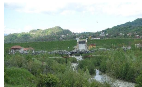
Râul Ialomița, podul de cale ferată și barajul Pucioasa -mai 2021-
